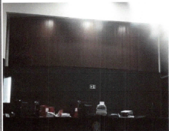
Plenário, painel vinil madeirado instalado.
