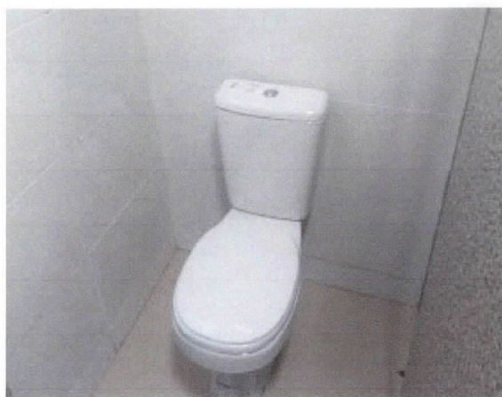
Instalação de kit de vaso sanitário, banheiros de gabinetes.
