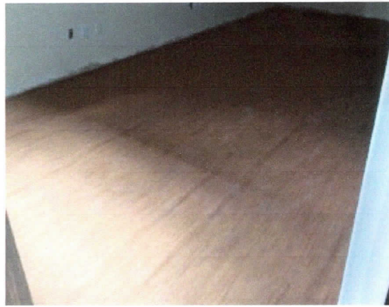
Piso vinil instalado, superior, administrativo.
