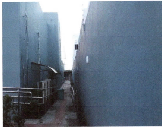
Pintura externa, acesso lateral ao plenário.
