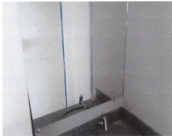
Instalação de espelhos, banheiros térreo..
