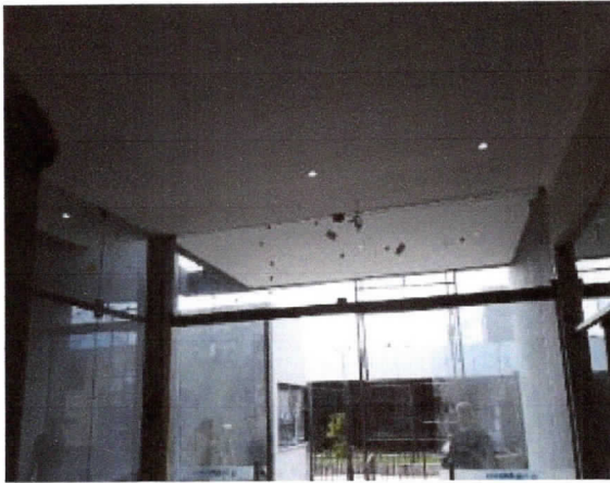
Esquadrias e vidros, painel e porta de acesso da recepção.
