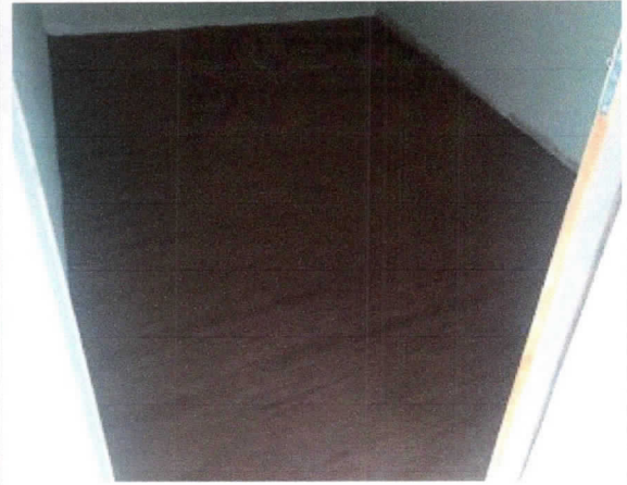
Piso vinil instalado, superior, diretoria legislativa.
