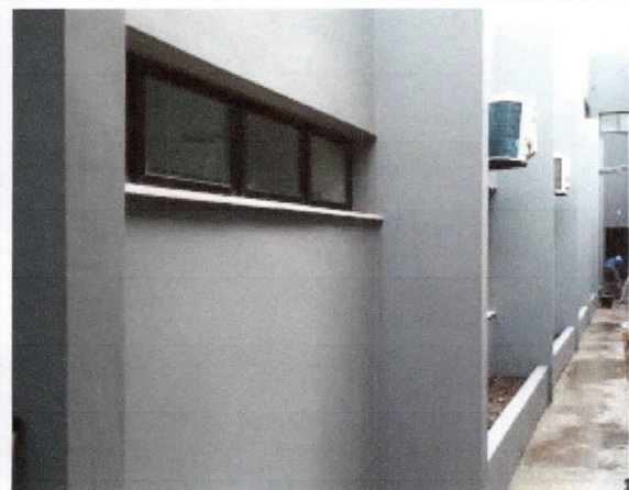
Pintura externa, circulação central.
