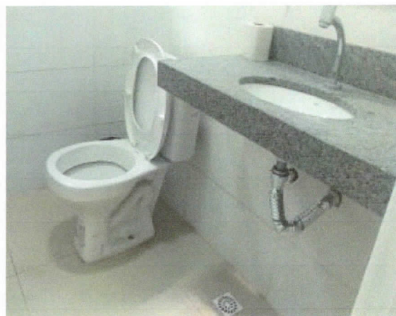
Vaso e bancada instalados, banheiros térreo.
