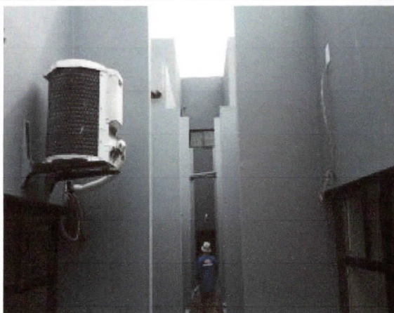
Pintura externa, circulação central.
