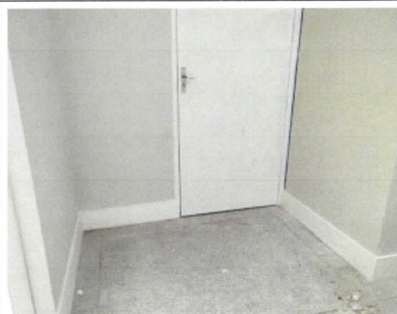
Piso de alta resistência finalizado, hall de banheiros.
