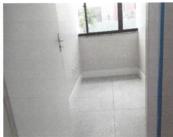
Piso de alta resistência finalizado, gabinetes.
