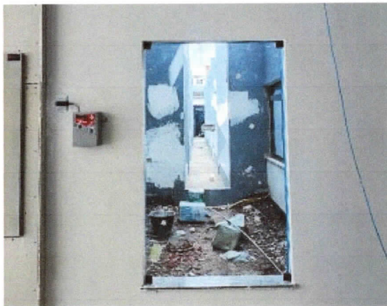
Esquadrias e vidros, painel da recepção.
