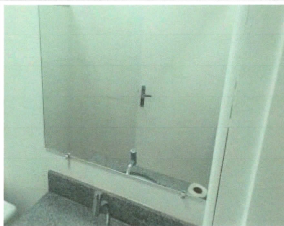
Instalação de espelhos, banheiros térreo.
