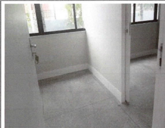
Piso de alta resistência finalizado, gabinetes.
