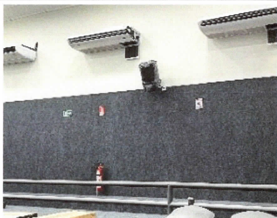
Plenário, reinstalação de climatização.
