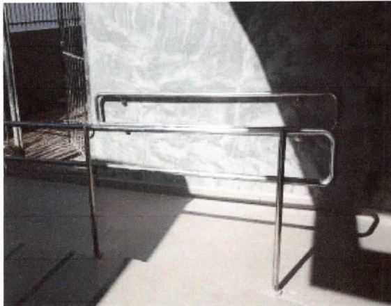
Reinstalação de corrimão inox, rampa de acessibilidade.
