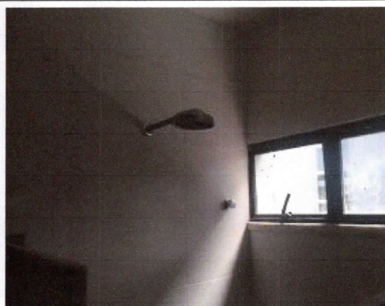
Instalação de kit de chuveiro, banheiros de gabinetes.
