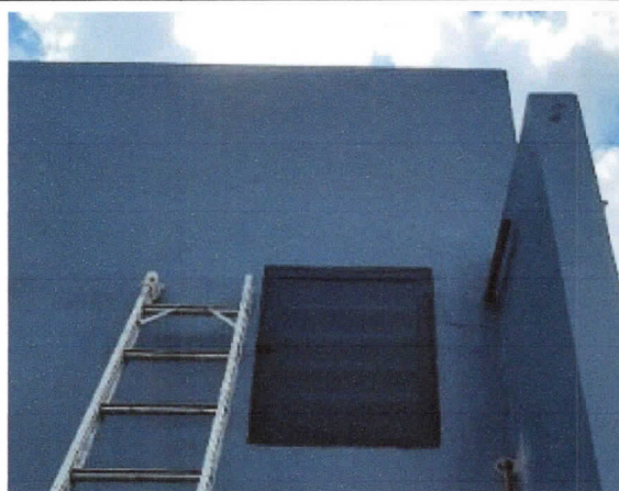
Esquadrias e vidros, porta de visita de caixa d'água.
