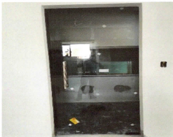
Esquadrias e vidros, porta de acesso sala do presidente.
