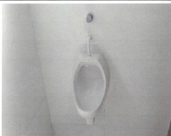
Instalação de kit de mictório, banheiros de gabinetes.
