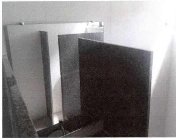
Instalação de espelhos, banheiros de gabinetes.
