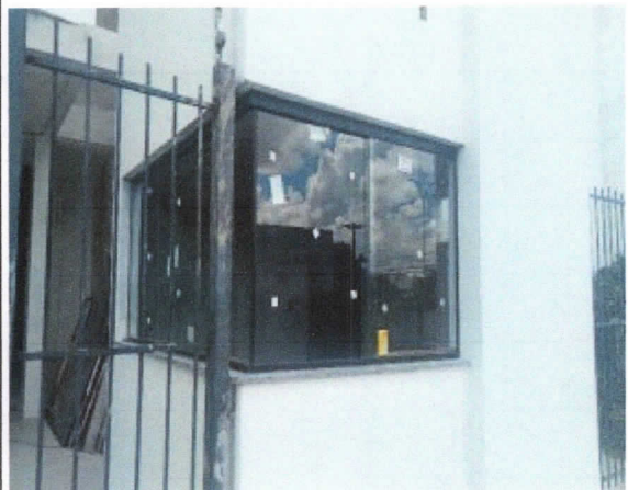
Esquadrias e vidros, guarita.
