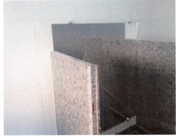
Instalação de espelhos, banheiros de gabinetes.
