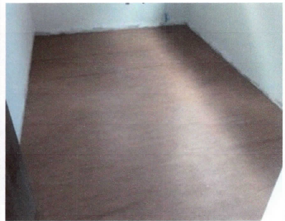
Piso vinil instalado, superior, diretoria geral.
