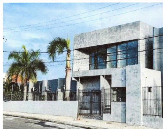
Pintura externa, muro, guarita e anexo superior, rua Sebastião Oliveira.
