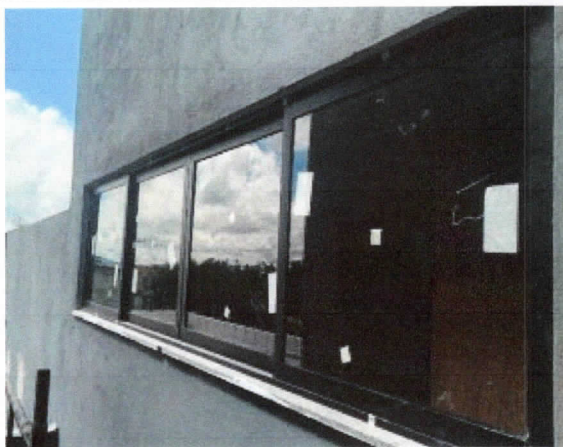
Esquadrias e vidros, superior, administrativo.
