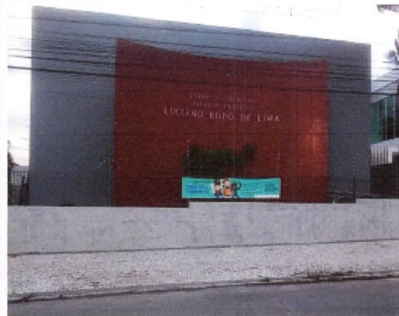
Pintura externa, muro e fachada avenida Dr. Luiz Magalhães.
