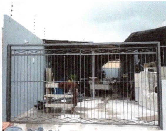
Pintura externa, acesso estacionamento interno.
