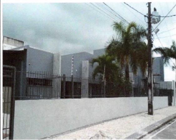
Pintura externa, muro e fachada rua Sebastião Oliveira.
