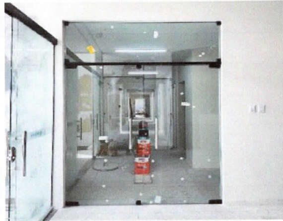
Esquadrias e vidros, porta de acesso I aos gabinetes.
