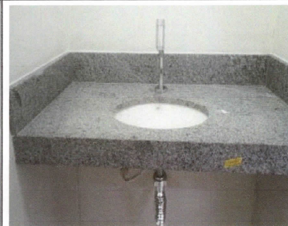
Instalação de bancada granito e metais sanitários, banheiros.
