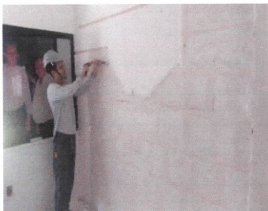
Demolição de reboco
