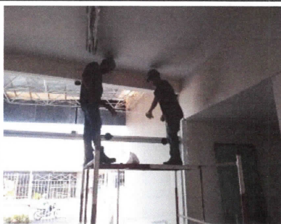
Remoção de vidro
