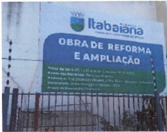
Instalação da placa da obra
