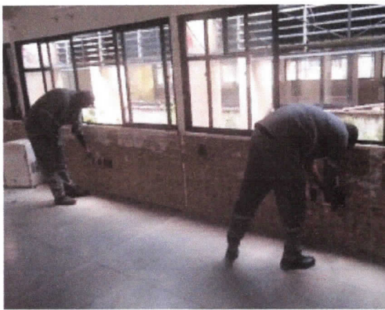
Remoção de interruptores e tomadas
