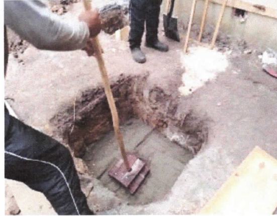
Reforço de solo para implantação de sapatas
