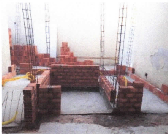
Alvenaria de vedação de blocos cerâmicos furados na horizontal de 9x19x29 cm (espessura 9 cm), elevador PNE.
