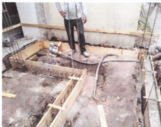
Lançamento de forma e armadura de baldrame.
