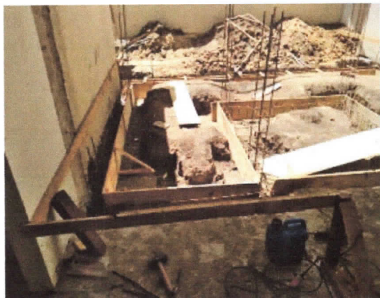
Locação de construção de edificação até 200m 2 , inclusive execução de gabarito de madeira.
