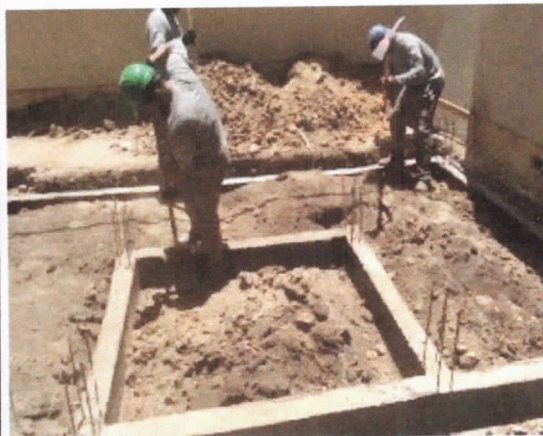
Reaterro manual de valas.
