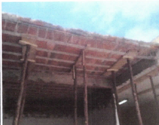
Escoramento de lajes para demolição de vigas.
