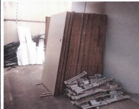
Demolição de divisórias tipo naval
