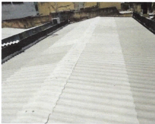
Telhamento com telha de fibrocimento ondulada esp. = 6mm, fixada com parafuso, com cumeeira.
