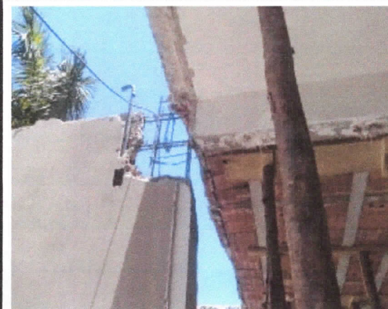
Demolição para prosseguimento de pilar.
