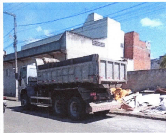
Transporte com caminhão basculante de 10 m 3 , em via urbana pavimentada, dmt até 30 km.
