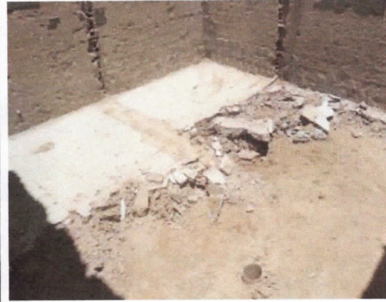
Demolição de piso cerâmico ou ladrilho
