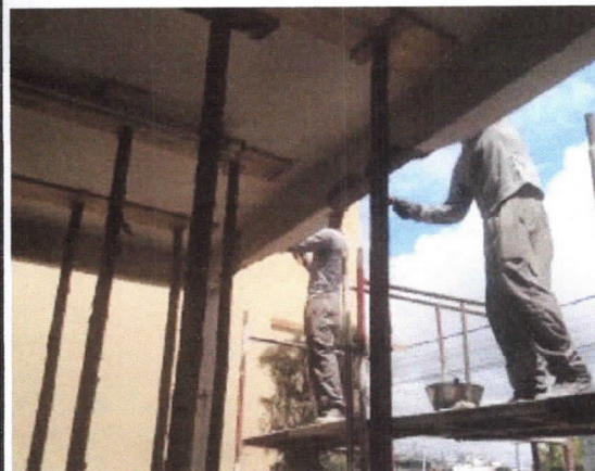
Demolição de vigas
