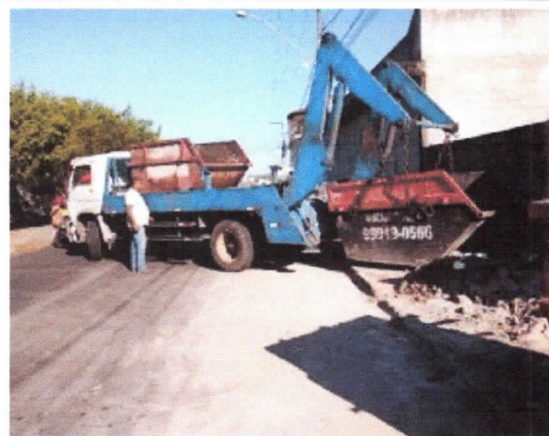
Descarte de resíduos da construção civil em área licenciada
