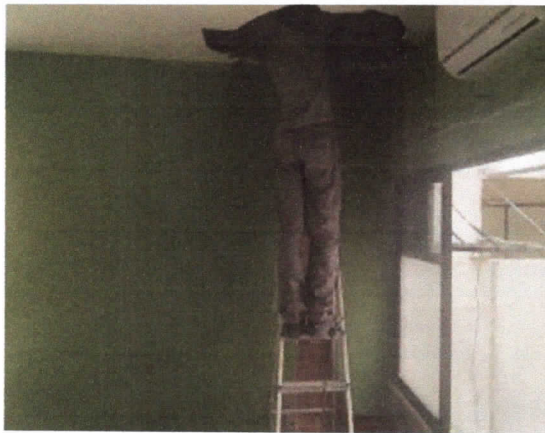
Lançamento de cabo flexível
