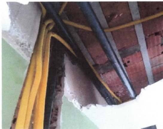
Instalação de eletrodutos e caixas em tetos..
