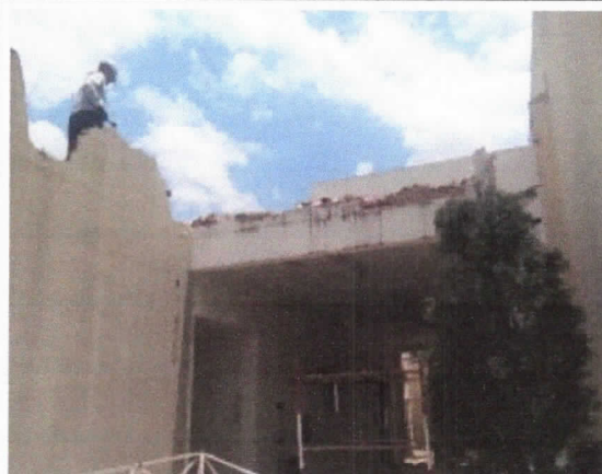
Demolição de alvenaria de bloco furado, de forma manual, sem reaproveitamento
