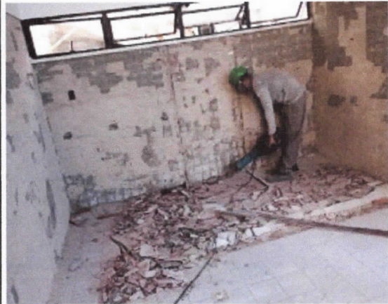
Demolição de revestimento cerâmico ou azulejo
