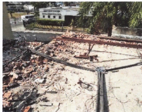
Demolição de alvenarias de platibandas
