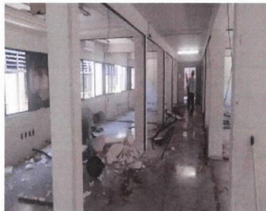
Demolição de divisórias tipo naval
