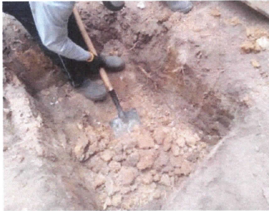
Escavação manual de vala ou cava em material de 1ª categoria, profundidade até 1,50m, sapatas.
