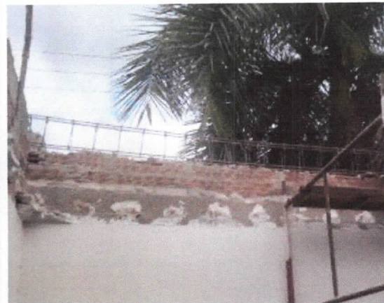
Demolição de concreto manualmente
