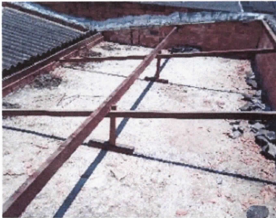
Remoção de telhas, de fibrocimento, metálica e cerâmica, de forma manual, sem reaproveitamento.
