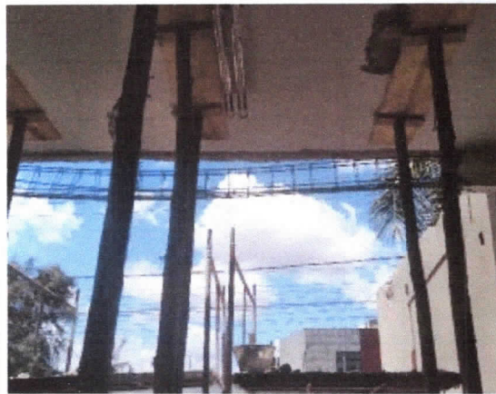
Escoramento de lajes para demolição de vigas.
