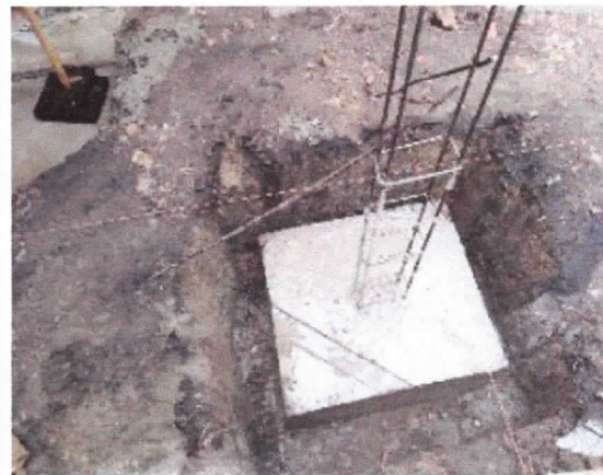
Concreto lançado e adensado em sapata.
