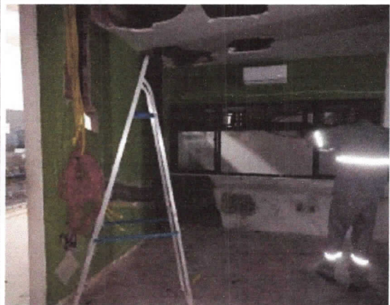
Lançamento de cabo flexível
