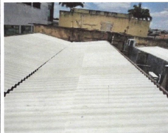
Telhamento com telha de fibrocimento ondulada esp. = 6mm, fixada com parafuso.
