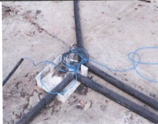
Remoção de tubos e caixas sobre lajes.
