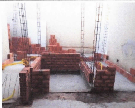
Alvenaria de elevação, escada e elevador PNE.
