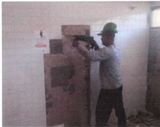
Demolição de revestimento cerâmico ou azulejo
