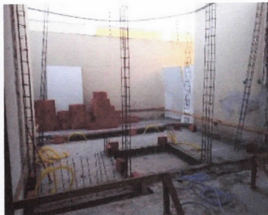
Lançamento de armaduras de pilares, escada e elevador PNE.
