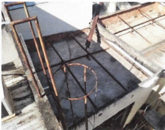
Remoção de trama de madeira para cobertura, de forma manual, sem reaproveitamento
