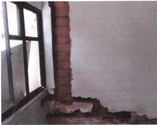
Rasgo em alvenaria para instalação de eletrodutos e caixas
