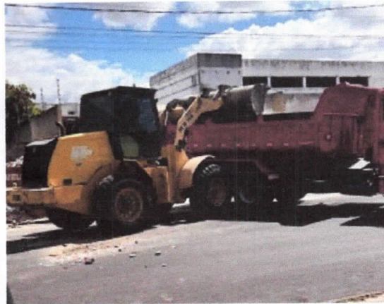
Carga, manobra e descarga de entulho em caminhão basculante 10 m 3 - carga com escavadeira hidráulica (caçamba de 0,80 m 3 / 111 hp) e descarga livre.
