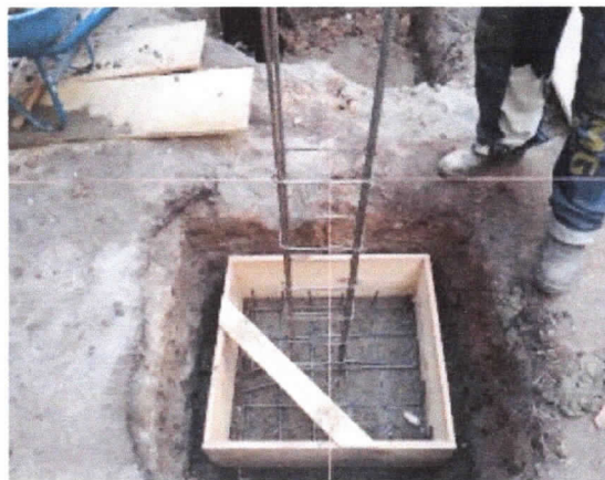
Lançamento de forma e armadura de sapata com arranque de pilar.
