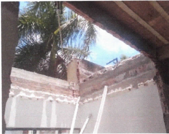
Demolição de laje
