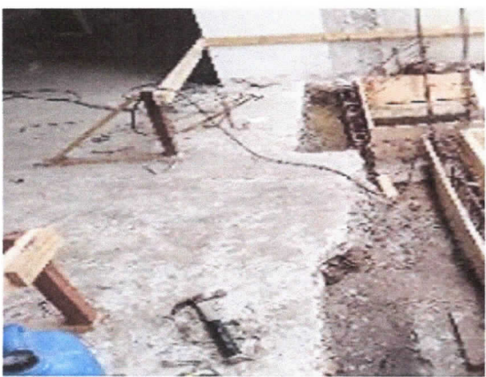
Demolição de piso de alta resistência
