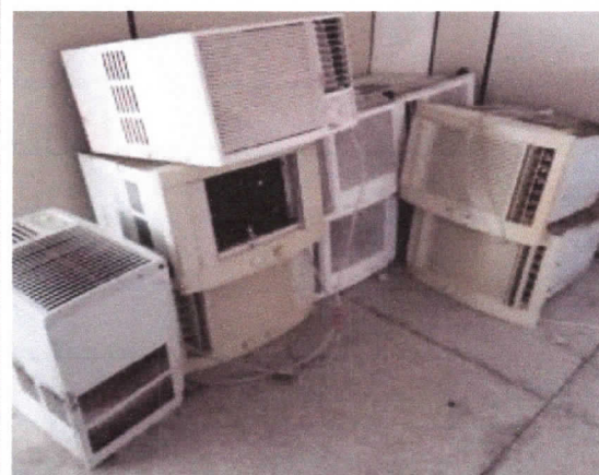
Remoção de equipamento ar condicionado
