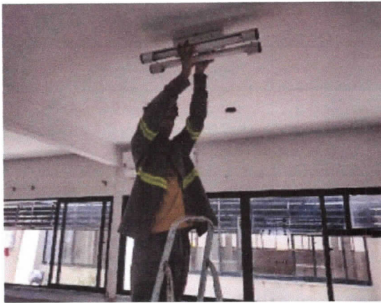
Remoção de luminária
