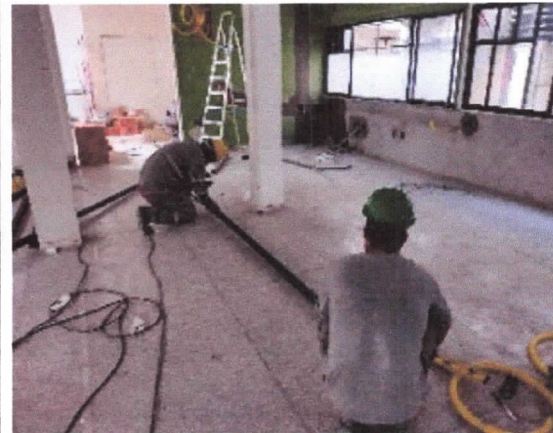
Montagem de estrutura de eletrodutos.
