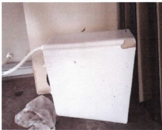
Remoção de acessórios sanitários
