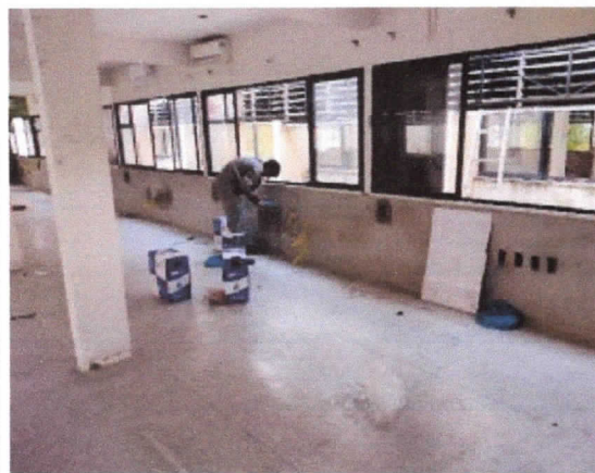
Lançamento de cabos 4 pares CAT6
