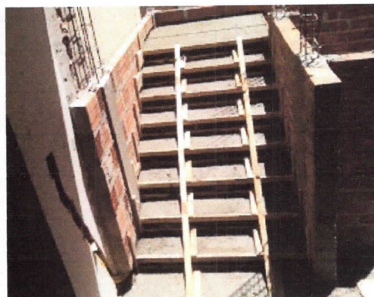
Escada, concretagem do 1º lance
