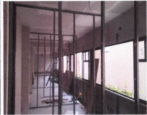
Elevações, montagem de estrutura para parede drywall
