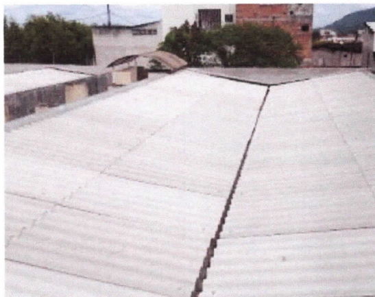
Coberturas, rufos de concreto armado sobre telhado de fibrocimento, finalizado
