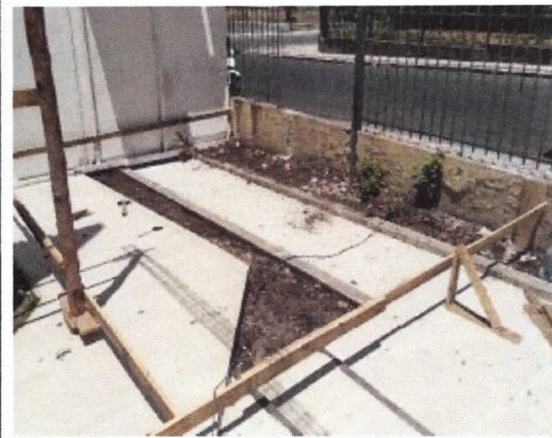
Guarita, gabarito de locação
