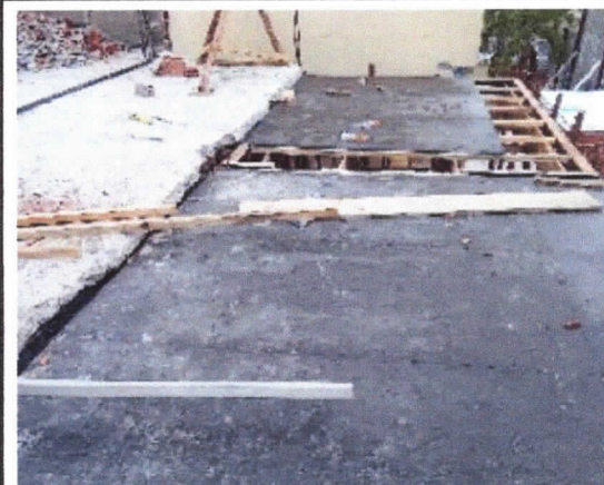
Estrutura, montagem de formas de lajes
