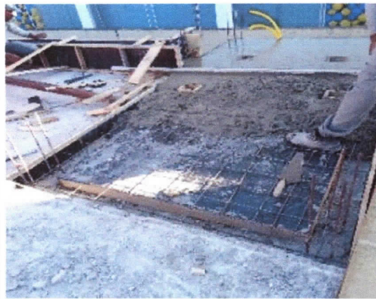
Estrutura, concretagem de lajes.
