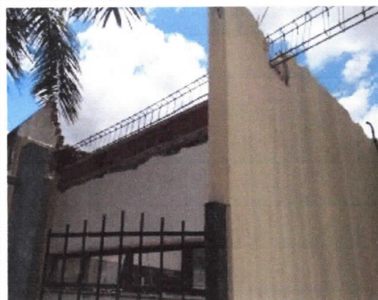
Estrutura, montagem e lançamento de armaduras de vigas
