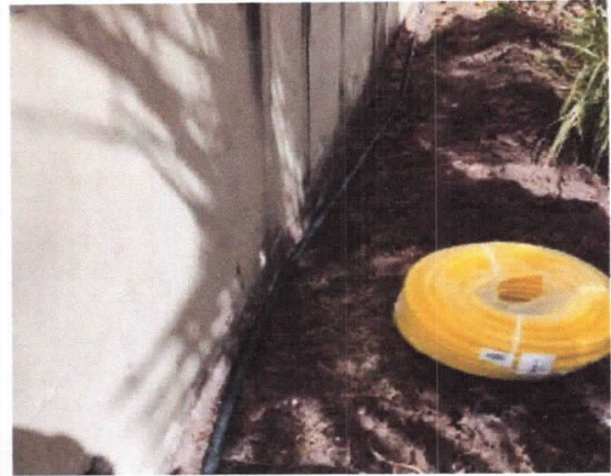
Elétrica, instalação de eletro dutos de iluminação externa
