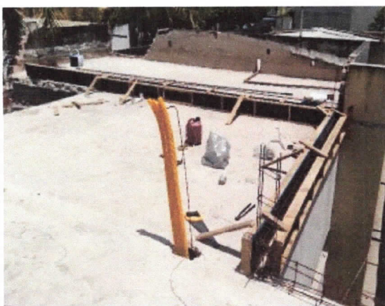
Estrutura, montagem e instalação de armadura e forma de cinta mento de amarração sobre lajes
