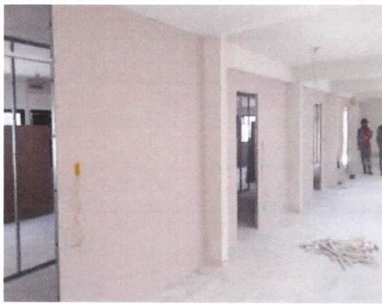
Elevações, montagem de fechamento de parede drywall
