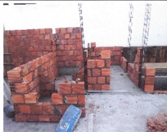
Alvenarias, elevação de paredes pavimento superior
