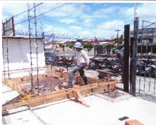
Guarita, forma de baldrame
