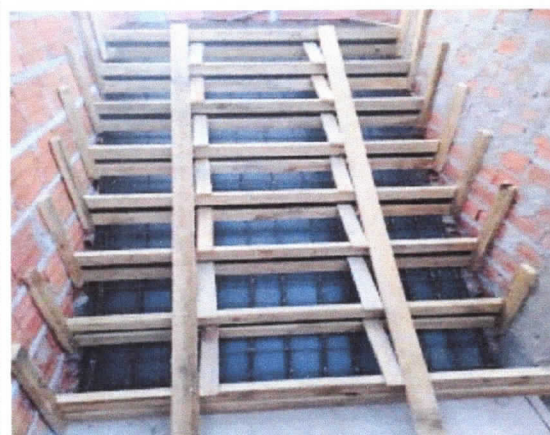
Escada, Forma e armadura do 2º lance
