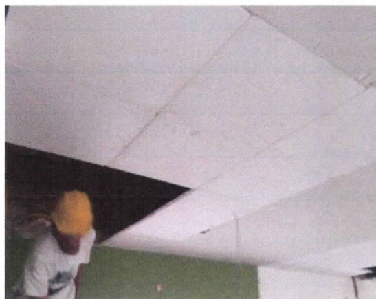
Coberturas, reposição de forro de placas de gesso
