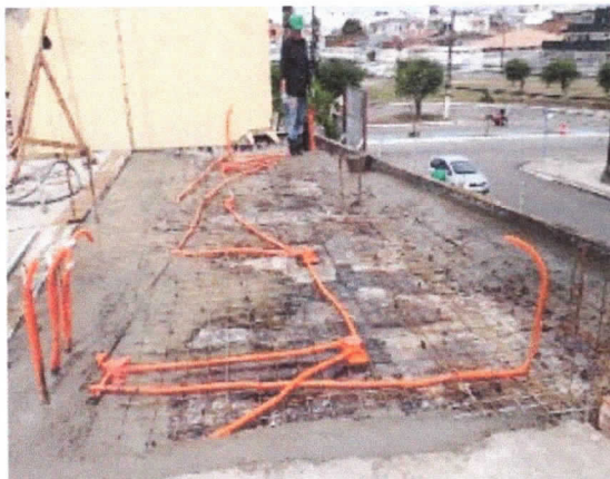
Estrutura, concretagem de lajes
