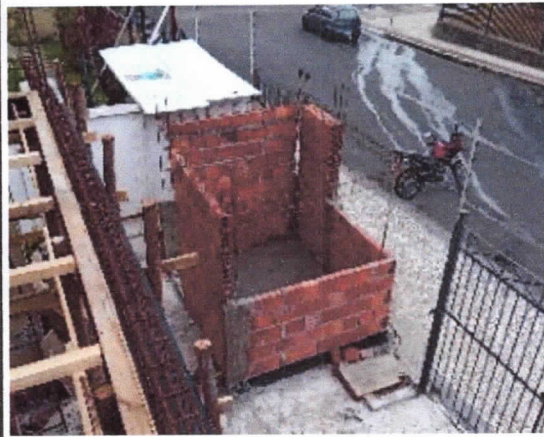
Guarita, execução de estrutura e elevação de paredes
