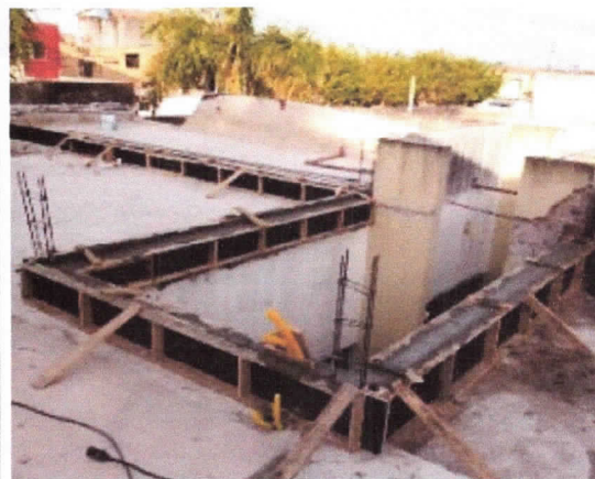
Estrutura, concretagem de cinta mento de amarração sobre lajes
