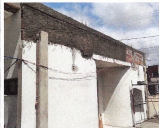
Coberturas, platibanda de cobertura metálica finalizado
