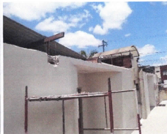
Coberturas, demolição de platibandas de cobertura metálica
