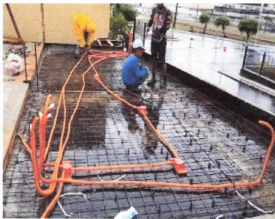
Elétrica, instalação de eletro dutos e caixas embutidos em laje
