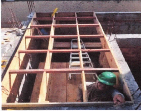
Estrutura, montagem e escoramento de formas de lajes
