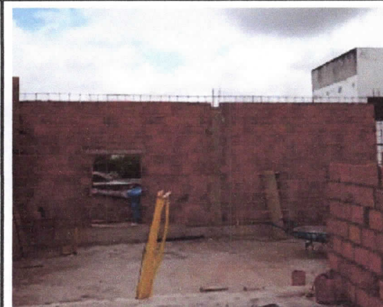
Alvenarias, elevação de paredes pavimento superior
