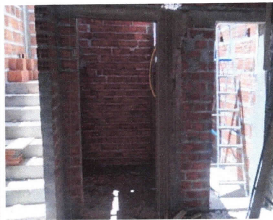
Elevador PNE, térreo, vãos de portas de acesso e manutenção.
