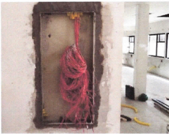
Elétrica, instalação de fios de centro de distribuição
