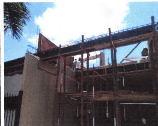
Estrutura, montagem e instalação de formas de vigas
