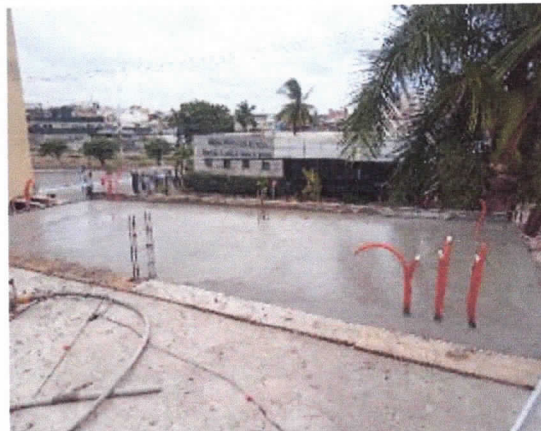
Estrutura, concretagem de lajes, finalizado
