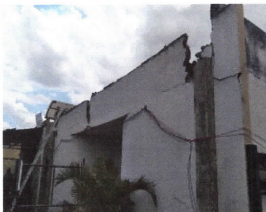
Cobertura metálica removida
