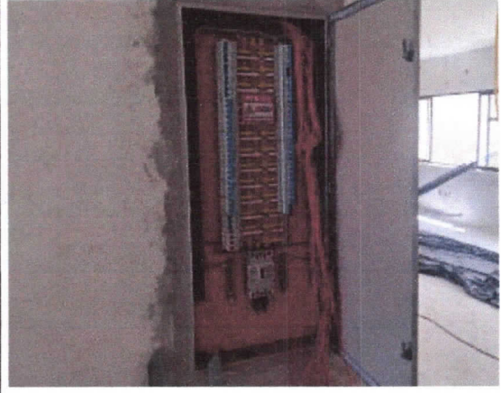
Elétrica, instalação de barramento e disjuntores de centro de distribuição
