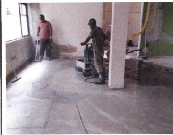
Pisos, polimento de piso de alta resistência, existente
