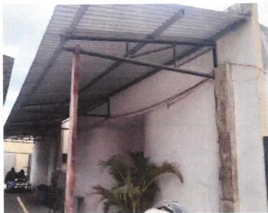
Cobertura metálica existente
