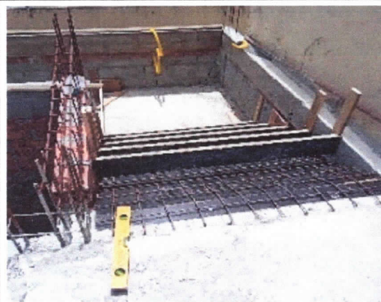
Escada, forma e armadura do 3º lance
