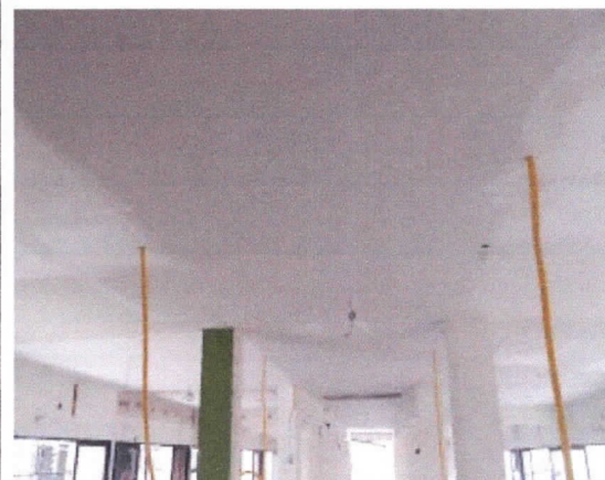
Coberturas, reposição de forro de placas de gesso finalizado
