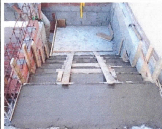
Escada, concretagem do 3º lance
