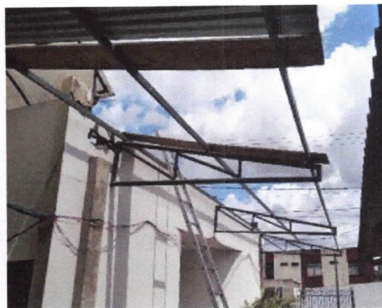
Remoção de cobertura metálica existente
