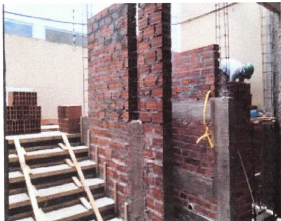
Elevador PNE, alvenaria do poço e casa de máquina
