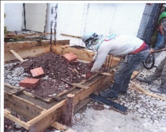
Guarita, concretagem de baldrame
