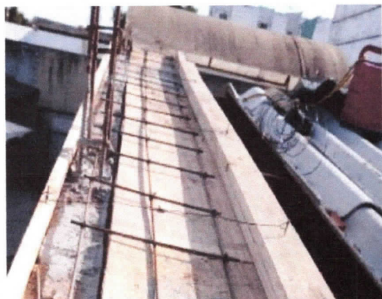
Coberturas, execução de rufo de concreto armado sobre telhado de fibrocimento
