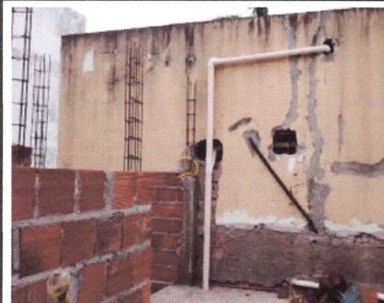
Águas pluviais, instalação de tubulação de coleta de calhas
