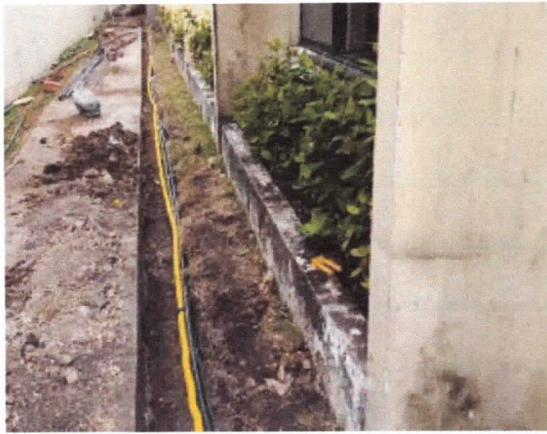
Elétrica, instalação de eletro dutos enterrados
