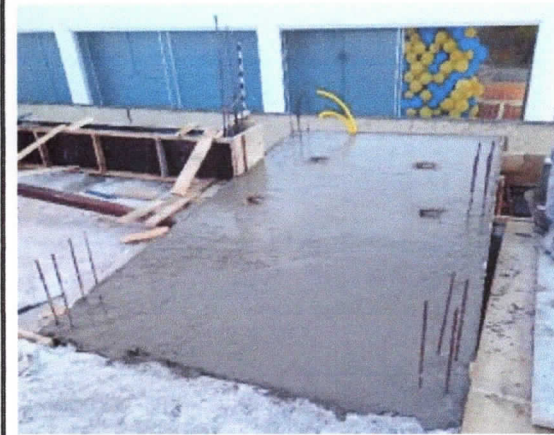
Estrutura, laje concretada
