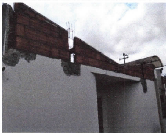
Coberturas, reforço de estrutura e alvenaria de platibandas
