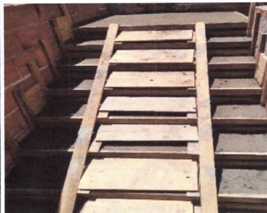
Escada, concretagem do 2º lance
