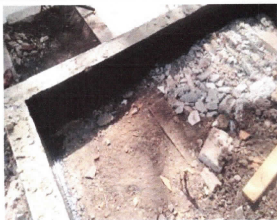
Guarita, impermeabilização de baldrame
