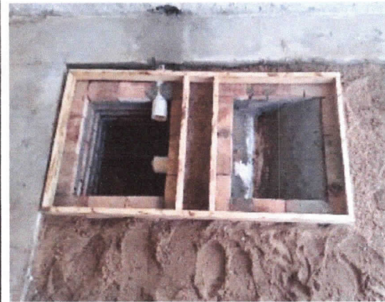
Esgoto Sanitário, instalação de caixas de passagem
