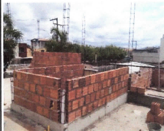
Alvenarias, elevação de paredes pavimento superior
