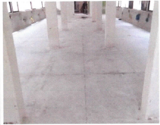
Pisos, polimento de piso de alta resistência, existente, finalizado
