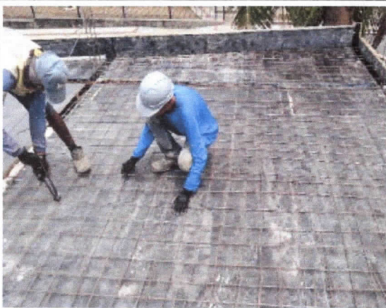
Estrutura, montagem de armadura de laje
