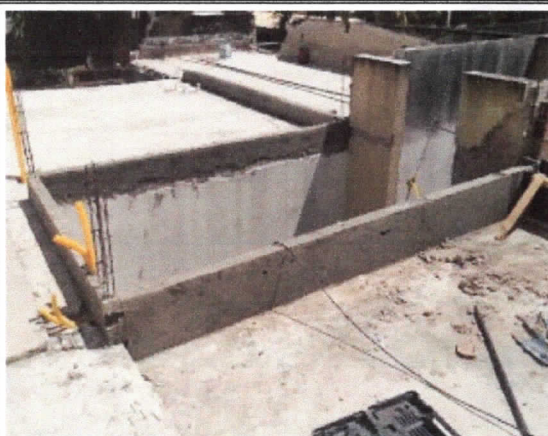
Estrutura, cinta mento de amarração sobre laje, finalizado
