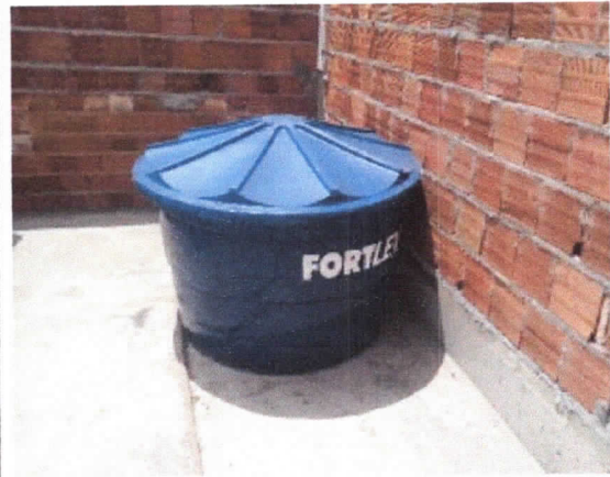
Hidráulica, caixa d'água de pvc capacidade 1000 litros
