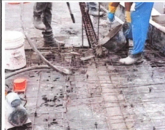
Estrutura, concretagem de vigas
