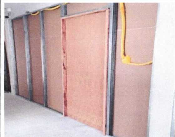
Elevações, instalação de portas de paredes drywall
