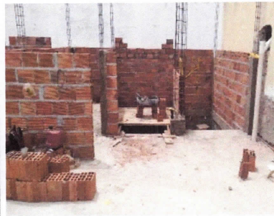
Elevador PNE, superior, elevação de paredes
