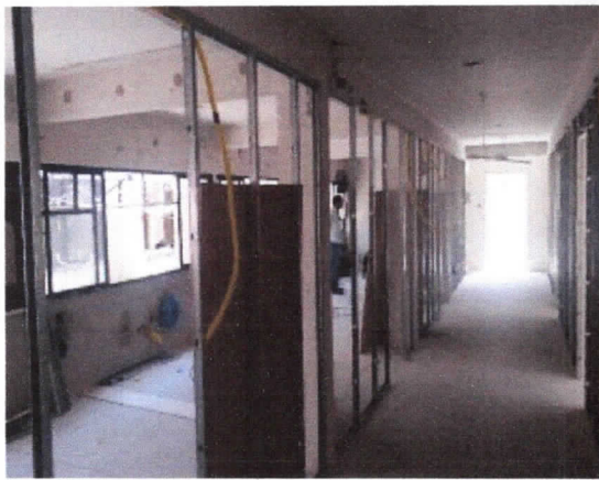
Elevações, montagem de estrutura para parede drywall
