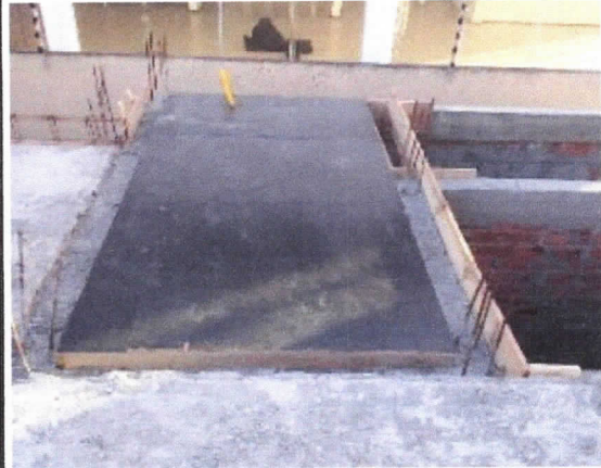
Estrutura, montagem de formas de lajes
