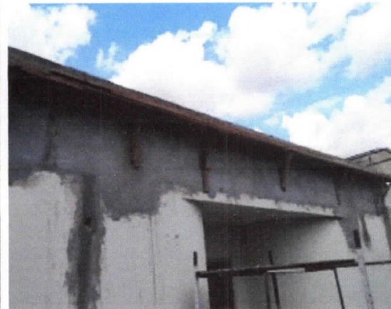
Coberturas, rufos de concreto armado para cobertura de telha metálica
