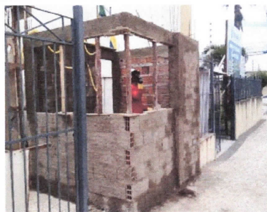
Guarita, chapisco de paredes
