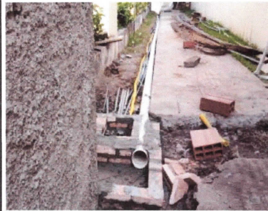
Esgoto Sanitário, instalação de linha de esgoto tubulação de 100mm
