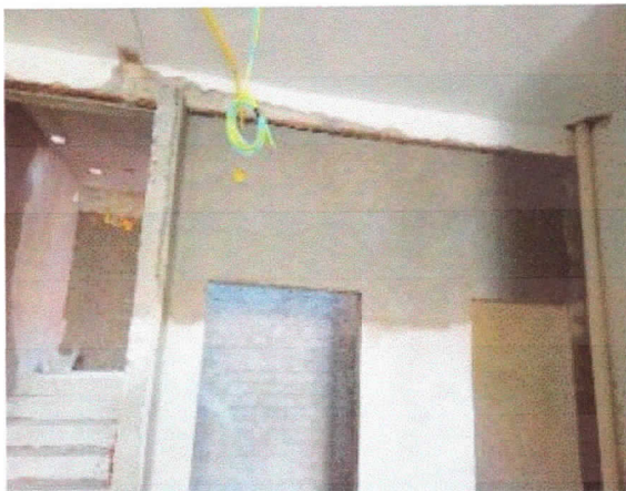
Revestimentos, reboco sobre paredes hall de escada e elevador PNE.
