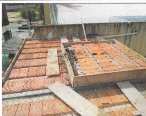
Estrutura, montagem de laje pré-fabricada, cobertura caixa de escada e poço elevador PNE.
