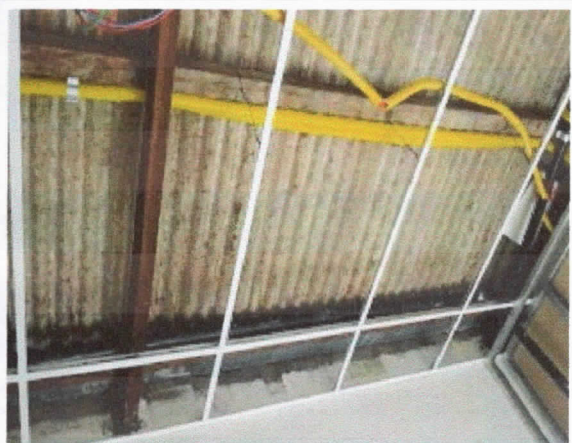
Elétrica, instalação de eletrodutos sob telhado sala de áudio e vídeo plenário.
