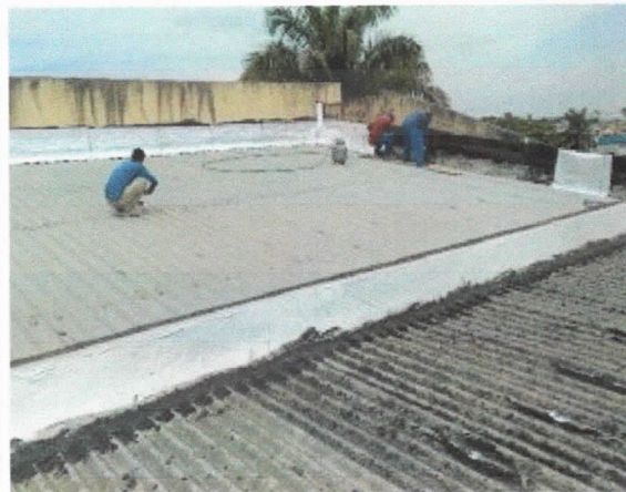
Cobertura do plenário, revisão e impermeabilização de platibandas e telhas.
