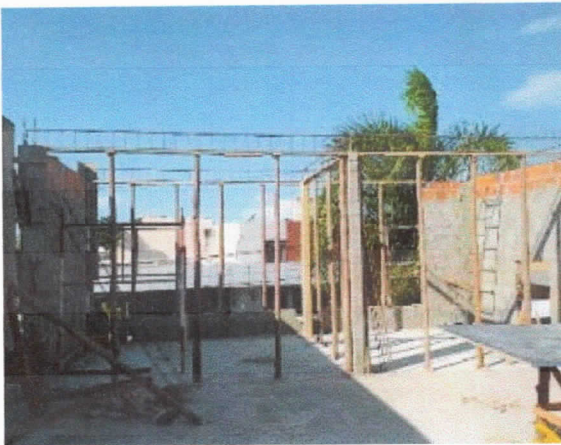
Estrutura, montagem de armaduras de vigas, laje superior.
