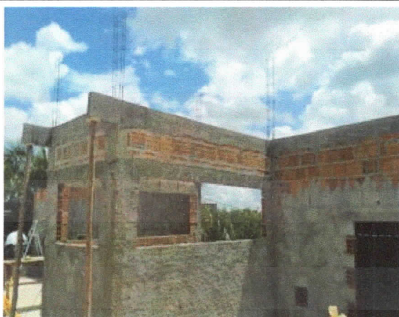
Estrutura, argolamento superior finalizado.
