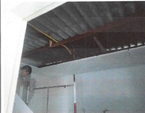
Coberturas, forro de placas de gesso, refeitório.
