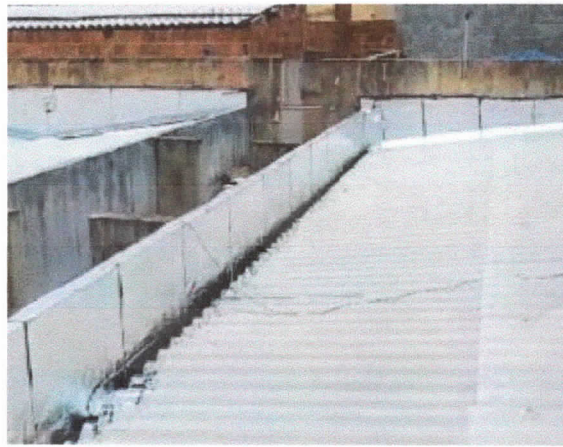
Coberturas, impermeabilização de platibandas com manta alumínio a quente finalizado, gabinetes.
