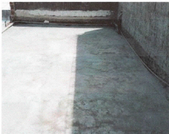
Coberturas, regularização de laje para impermeabilização, gabinetes.
