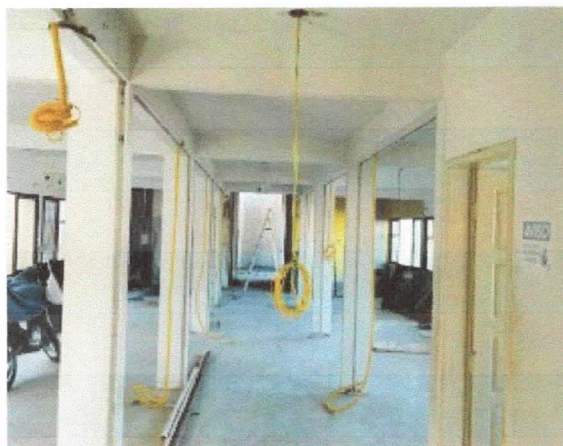
Elétrica, instalação de fiação de iluminação de gabinetes.
