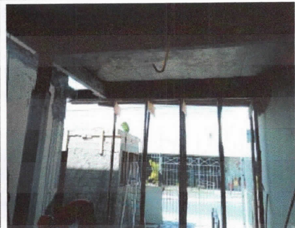
Estrutura, desmontagem de formas de lajes térreo.
