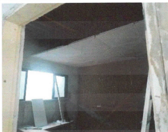
Coberturas, forro de placas de gesso, cozinha.
