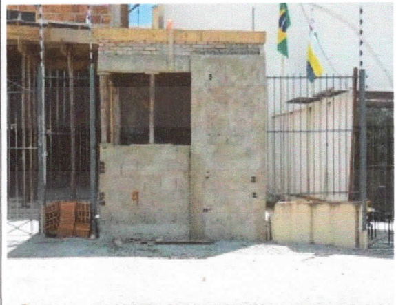
Guarita, reposição de gradil existente.
