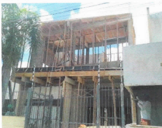
Estrutura, montagem de laje pré-fabricada de cobertura.
