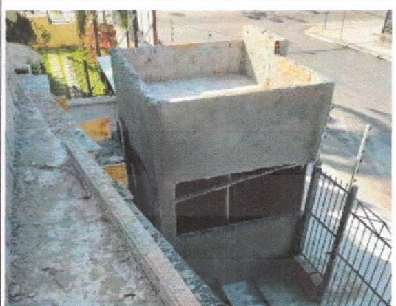
Guarita, reboco sobre paredes.
