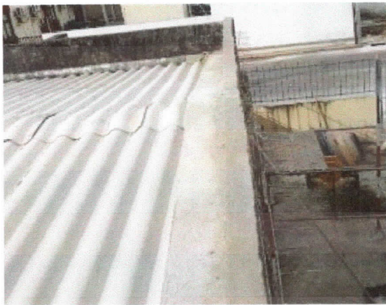
Coberturas, rufo de concreto armado finalizado
