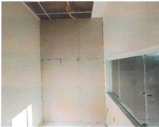
Elevações, parede drywall, sala de áudio e vídeo plenário.
