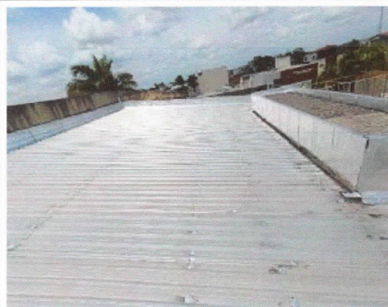
Cobertura do plenário, revisada e impermeabilizada.
