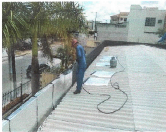
Coberturas, impermeabilização de platibandas com manta alumínio a quente, gabinetes.
