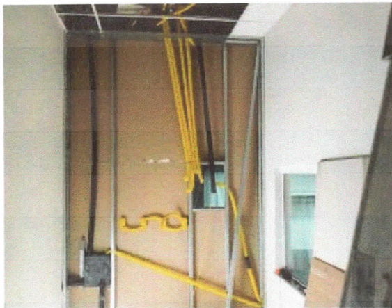
Elétrica, instalação de eletro dutos , caixa de passagem, centro de distribuição em parede drywall, sala de áudio e vídeo plenário.
