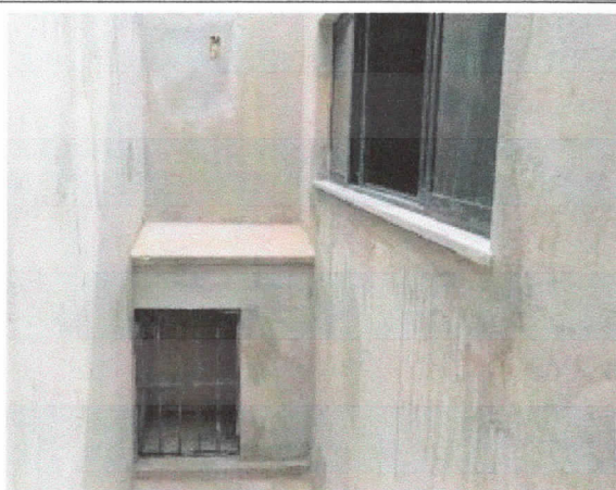
Esquadrias, assentamento de peitoril e janela alumínio cozinha, casa de gás.
