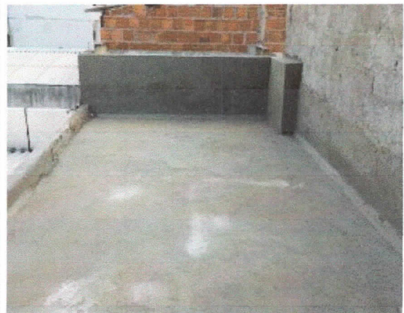
Coberturas, regularização de laje para impermeabilização, gabinetes.
