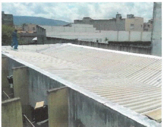
Coberturas, impermeabilização de algeroz e rufos com manta alumínio a quente finalizado, gabinetes.
