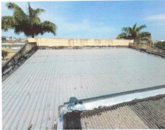
Cobertura do plenário, existente.
