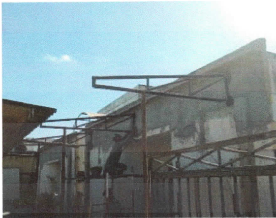
Coberturas, reinstalação de estrutura metálica.
