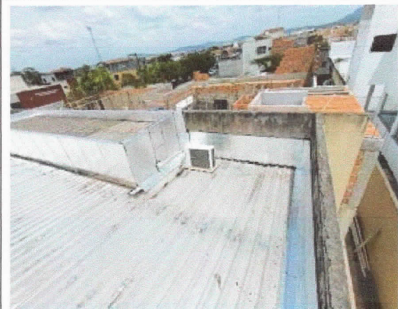
Cobertura do plenário, revisada e impermeabilizada.
