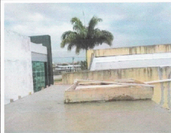
Estrutura, concretagem de laje pré-fabricada, cobertura caixa de escada e poço elevador PNE.
