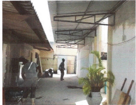
Coberturas, reinstalação de cobertura metálica finalizada
