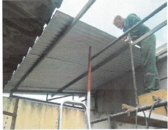
Coberturas, reinstalação de telhas metálicas.
