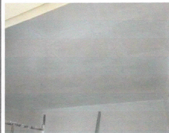
Coberturas, forro de placas de gesso, refeitório finalizado.
