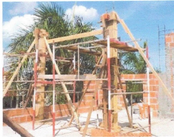
Estrutura, montagem de formas de pilares, laje superior.
