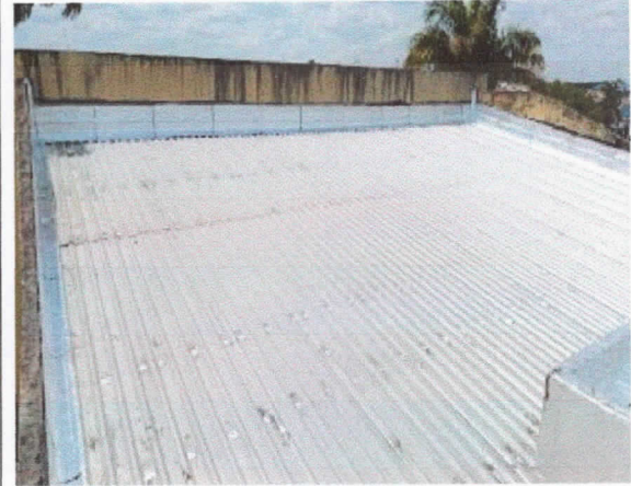
Cobertura do plenário, revisada e impermeabilizada.
