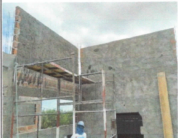
Elevações, execução de platibandas da cobertura do superior.
