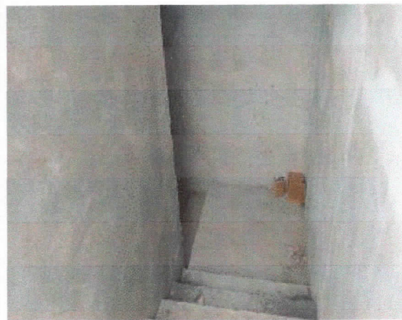
Revestimentos, reboco de paredes, escada.
