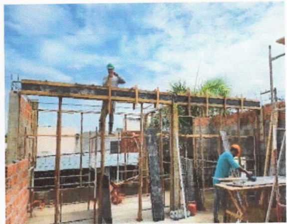
Estrutura, montagem de formas de vigas, laje superior.
