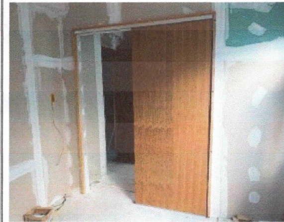
Elevações, regularização de placas de paredes drywall, gabinetes.
