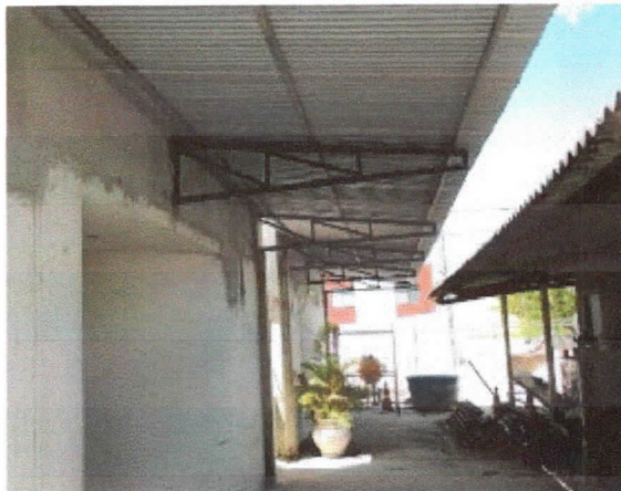
Coberturas, reinstalação de cobertura metálica finalizada.
