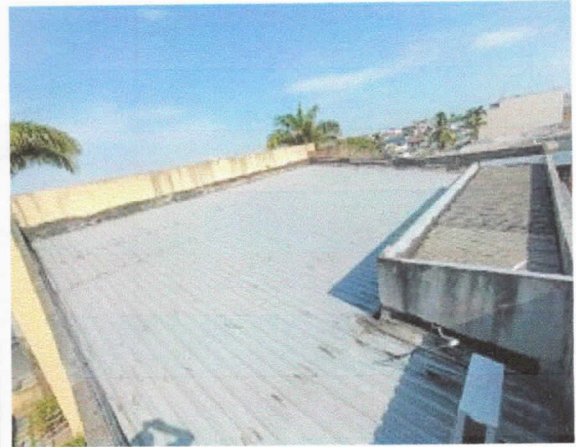
Cobertura do plenário, existente.
