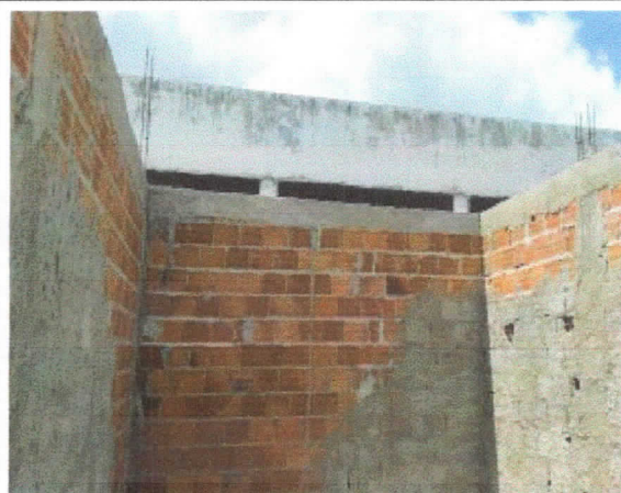
Estrutura, argolamento superior finalizado.
