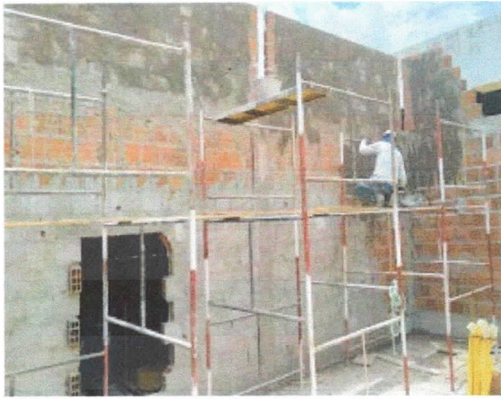
Elevações, paredes do administrativo, superior.
