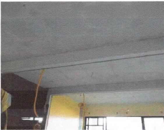
Coberturas, forro de placas de gesso, gabinetes finalizado
