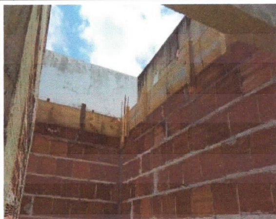
Estrutura, montagem de formas de argolamento superior.
