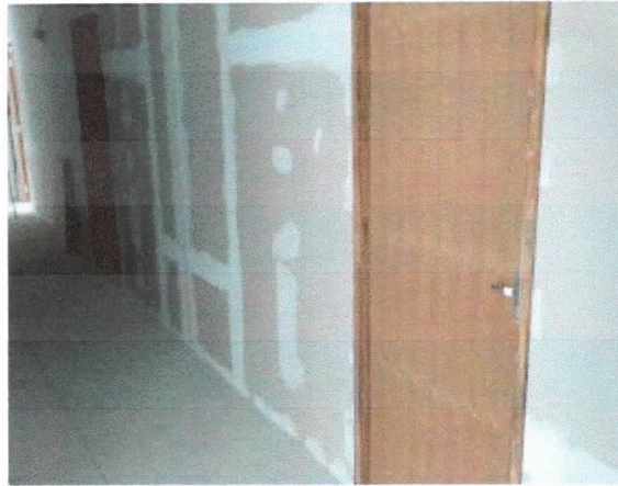
Elevações, regularização de placas de paredes drywall, circulação gabinetes.
