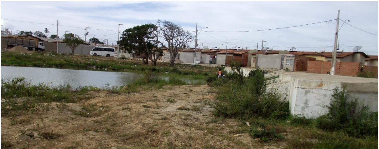
Figura 8.47: Açude formado próximo à estrutura de concreto.
