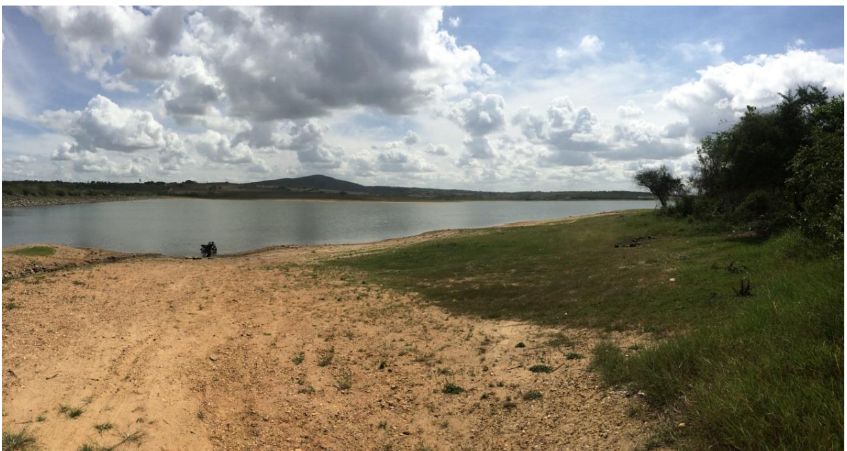
Figura 8.8: Barragem da Cajaíba
