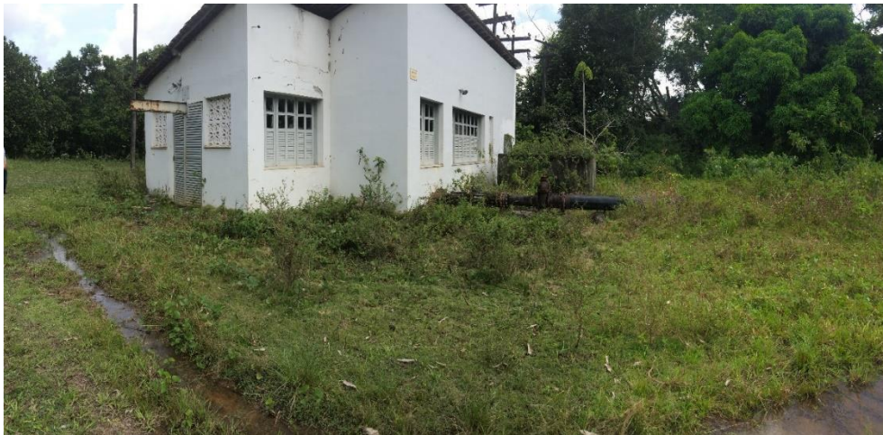
Figura 8.14: Casa de Bombas vista 2
