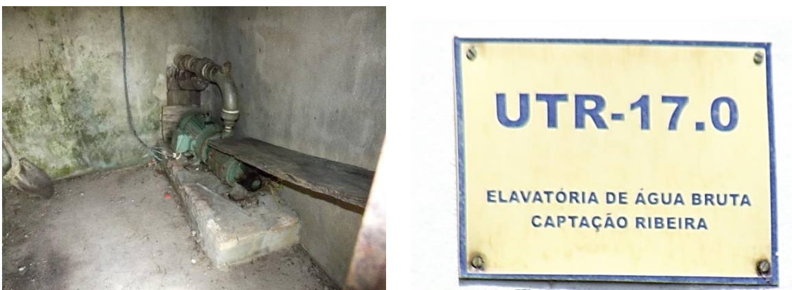
Figura 8.5: Captação Ribeira – situação geral
