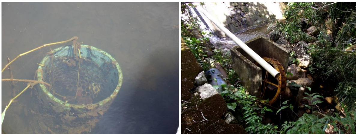
Figura 8.12: Captação Ribeira – situação geral
