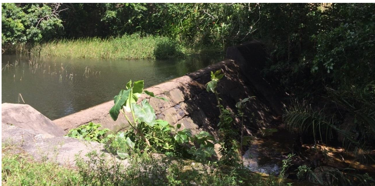
Figura 8.3: Barramento de nível de montante da captação
