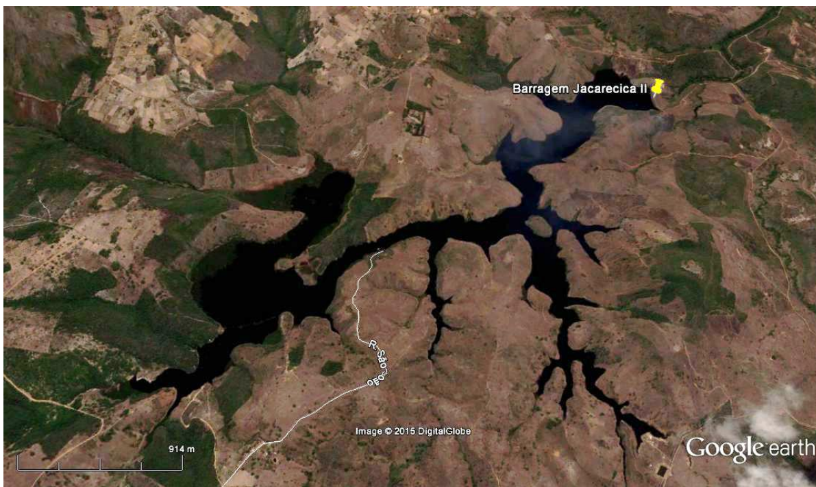
Figura 8.9: Reservatório Jacarecica II
