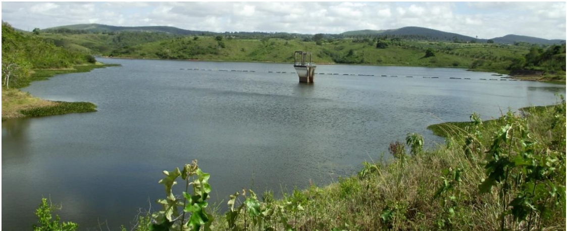
Figura 8.21: Estrutura na Barragem Jacarecica II
