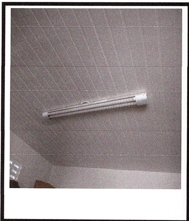
FOTO 21 – Ponto de luz e pintura
